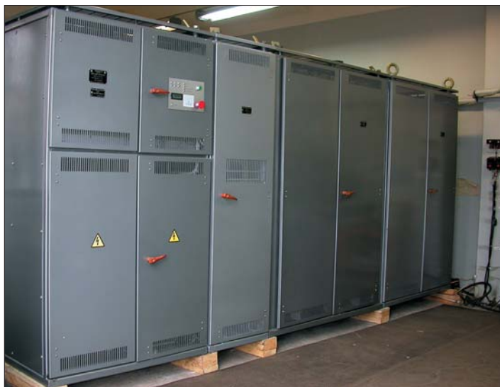
Рис. 2. Фотография преобразователя частоты ВПЧА-1000-6,3/6,0-50
