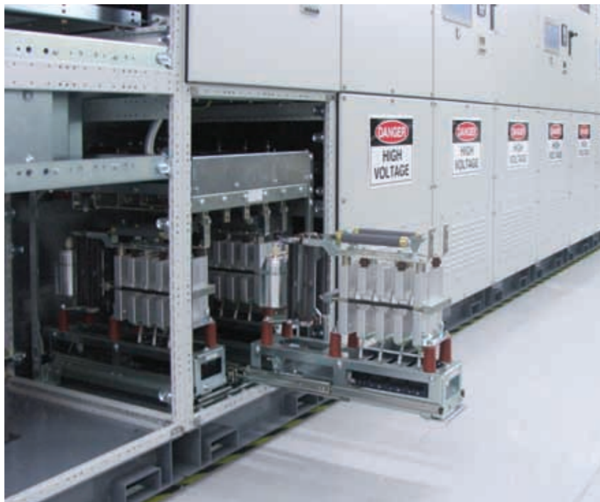
Выдвижная фазная сборка. Конструкция MVS делает монтаж и обслуживания простым и удобным.
